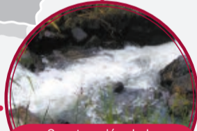
Construcción de la lateral sur de la quebrada Altavista entre Cra. 84F y 96 y obras complementarias $25.000 millones
